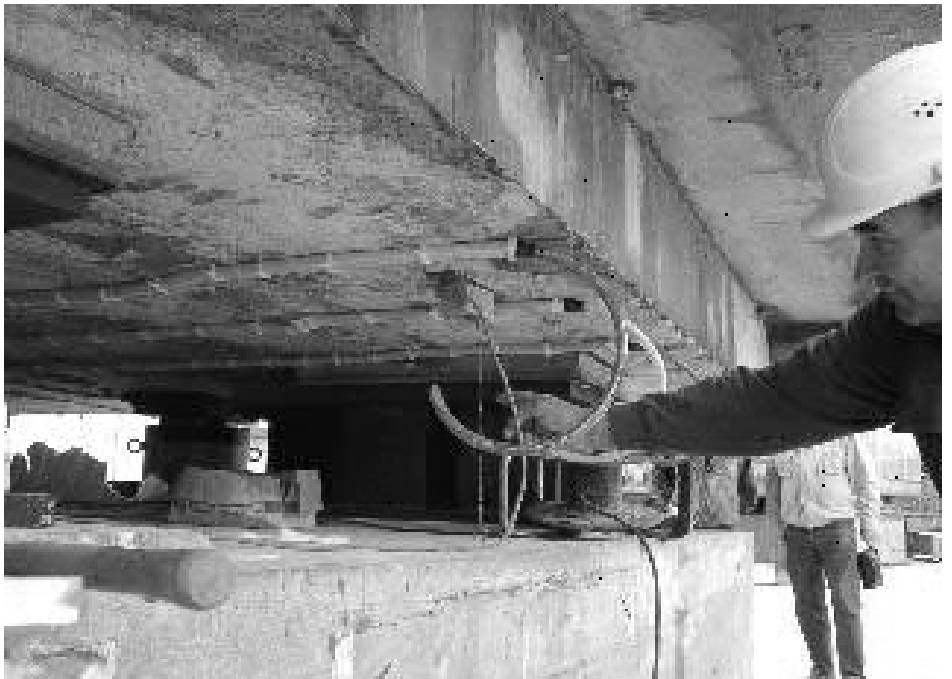
Injektionsschläuche zur Zementverpressung
