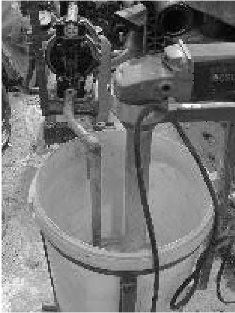
Zementmischer Rührwerk im Einsatz
