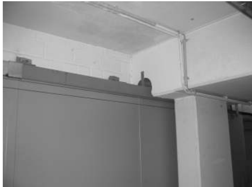
Feuerschutztor nach der Sanierungsmaßnahme
