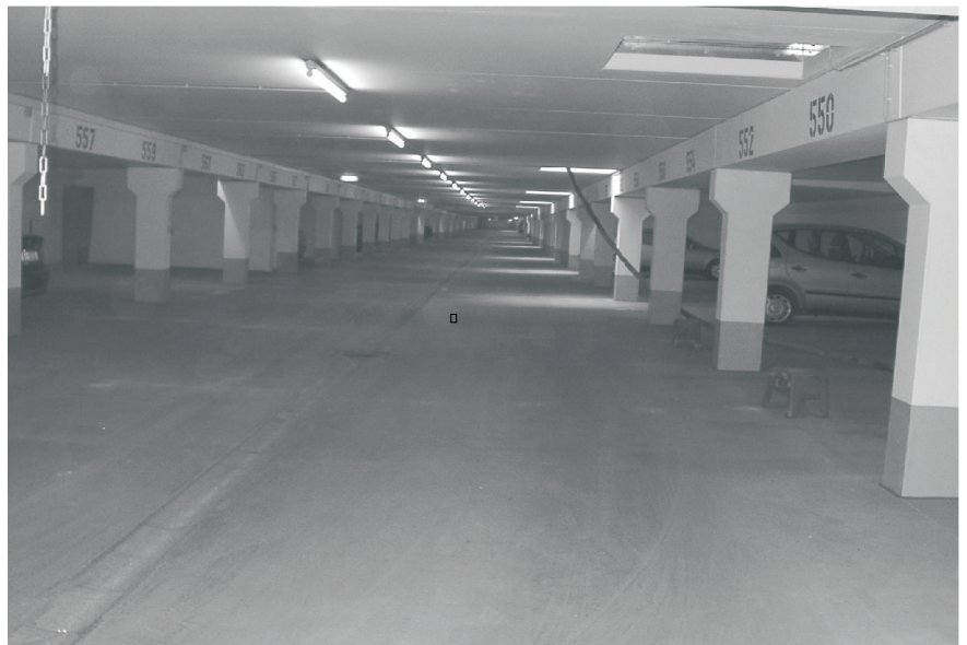
Tiefgaragenanlage mit sanierter Bodenplatte
